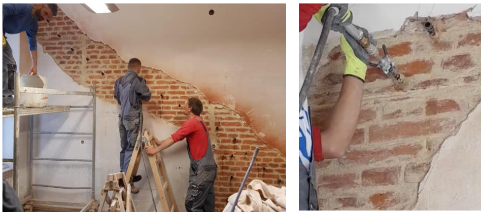
Slika 10: Prikaz postupka injektiranja zidova
