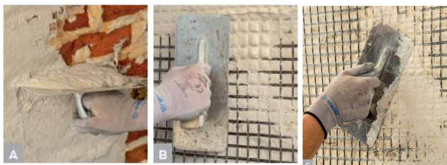
Slika 11: Prikaz postupka izvedbe FRCM sustava
