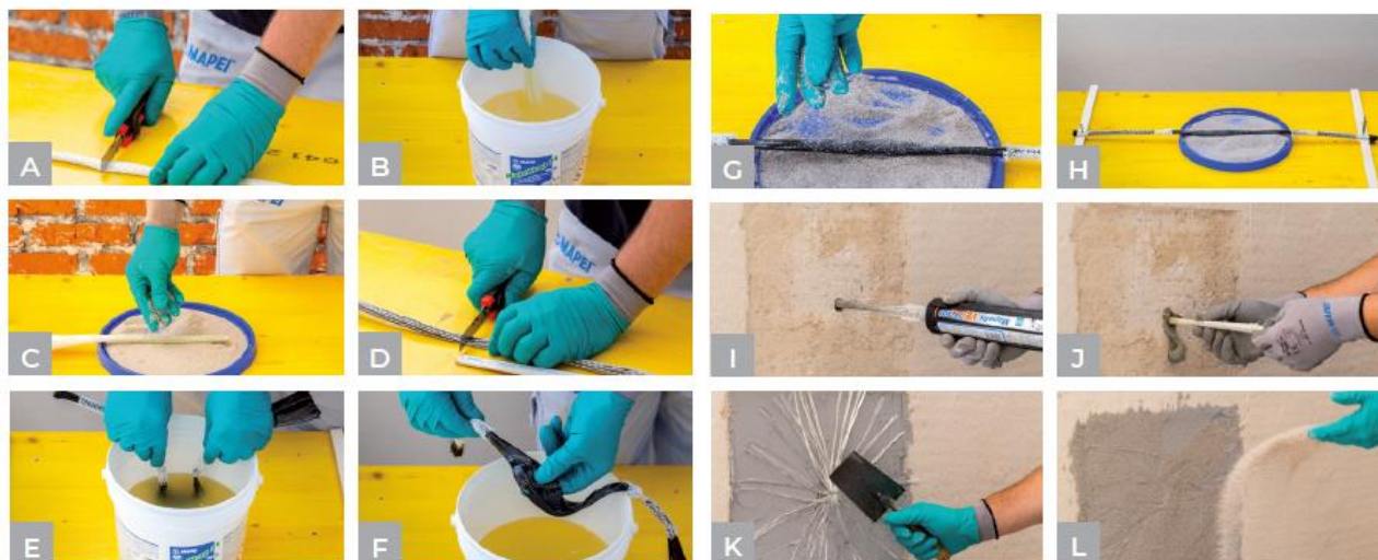
Slika 15: Postupak pripreme i izvođenja FIOCCO užadi
