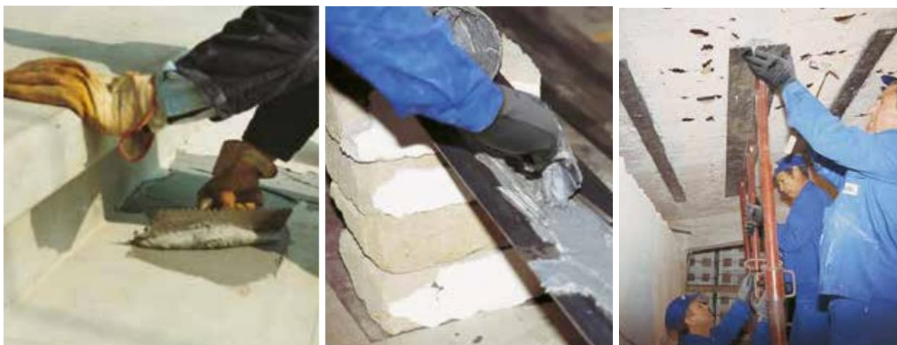
Slika 27: Postupak ljepljenja čeličnih lamela
