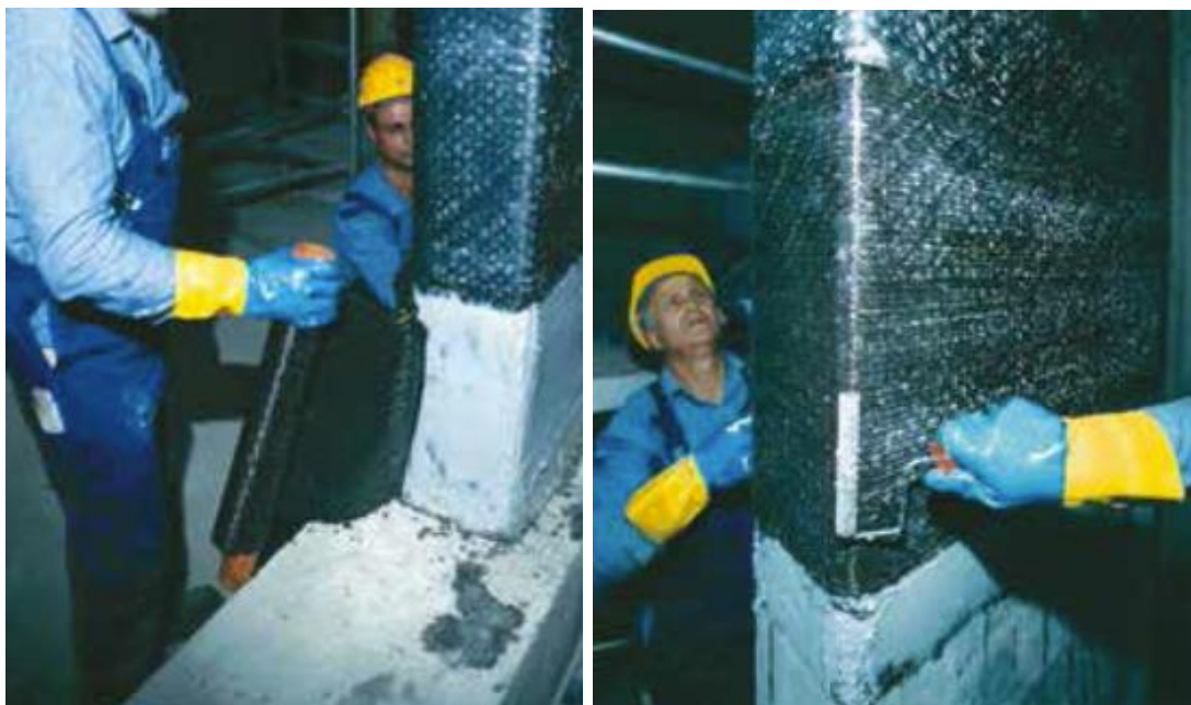
Slika 21: Nanošenje tkanine i poravnanje valjkom
