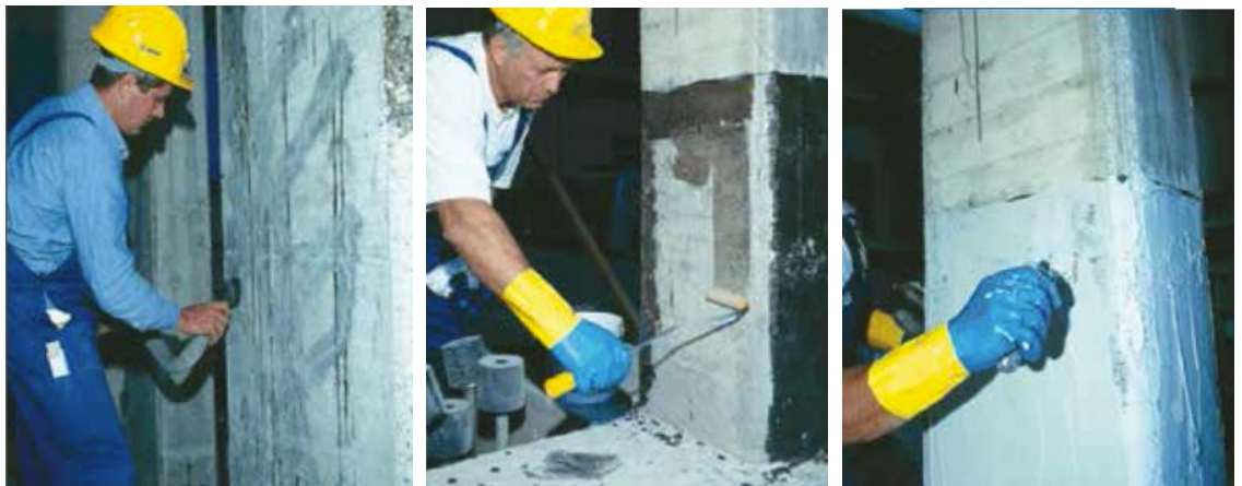
Slika 20: Priprema površine, nanos MapeWrap Primer 1 i nanos MapeWrap 11 ili 12 (s lijeva na desno)
